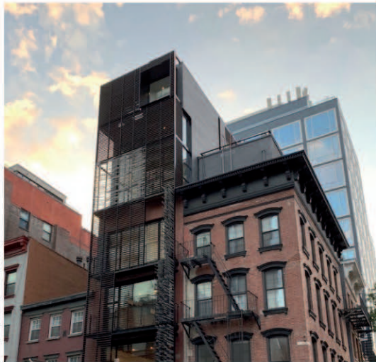
Mehrfamilienhaus 512 GW in Soho/New York. © Archi-Tectonics
